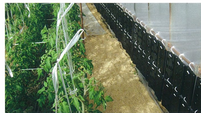
フックによる取付完了
